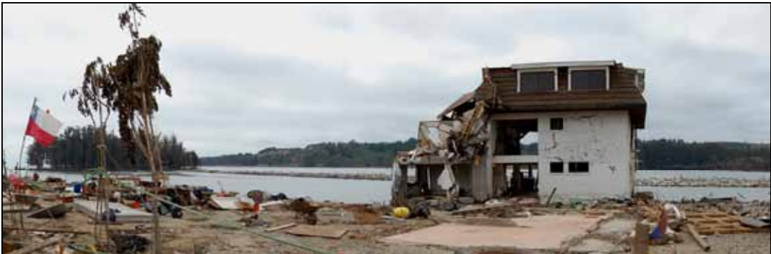
Figura 2-5: Falla en casa ubicada en la ribera del Río Maule, VII Región.
