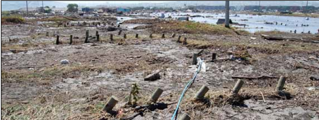
Figura 2-1: Falla de viviendas livianas en Llo-lleo, V Región.
