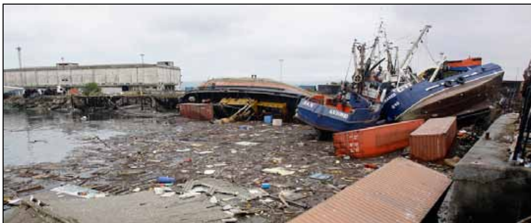
Figura 2-10: Daños mayores en Puerto de Talcahuano, VIII Región.
