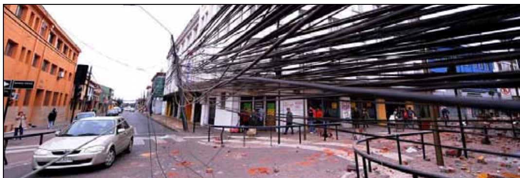
Figura 2-12: Falla de cables telefónicos y eléctricos en Concepción, VIII Región.
