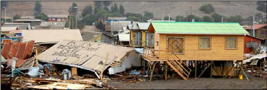
Figura 2-4: Falla de diferentes tipologías estructurales en Iloca, VII Región.
